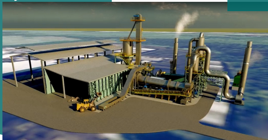
Planta de carbonização (conversão termoquímica) da Tecnored
